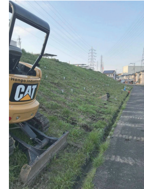
↑法面での作業は安全対策必須です
