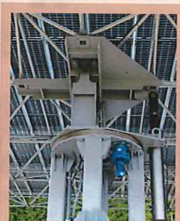
本郷工業が自社開発した太陽光追尾式架台システム。巨大太陽光パネルを支え、発電効率を最大化する。
