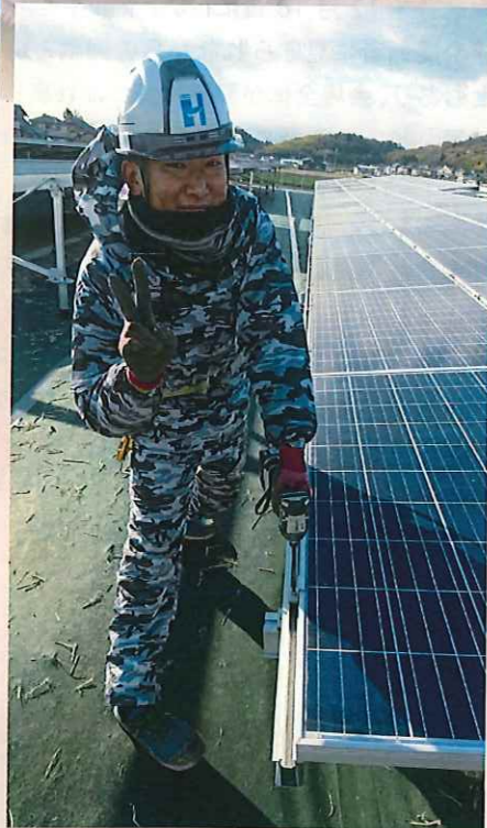
寒風吹き抜ける現場で太陽光発電を設置する佐藤
