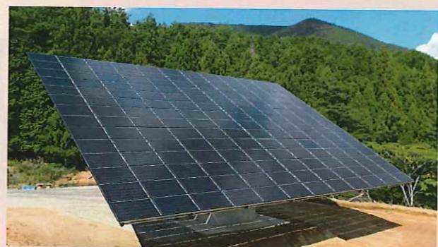
滋賀県甲賀市土山町の商用機。最新式の太陽光追尾式架台システムを採用している
